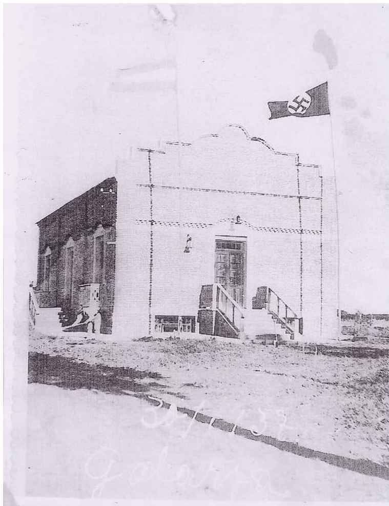
Figura 4. Edificio de la escuela alemana “La Germánica”.
