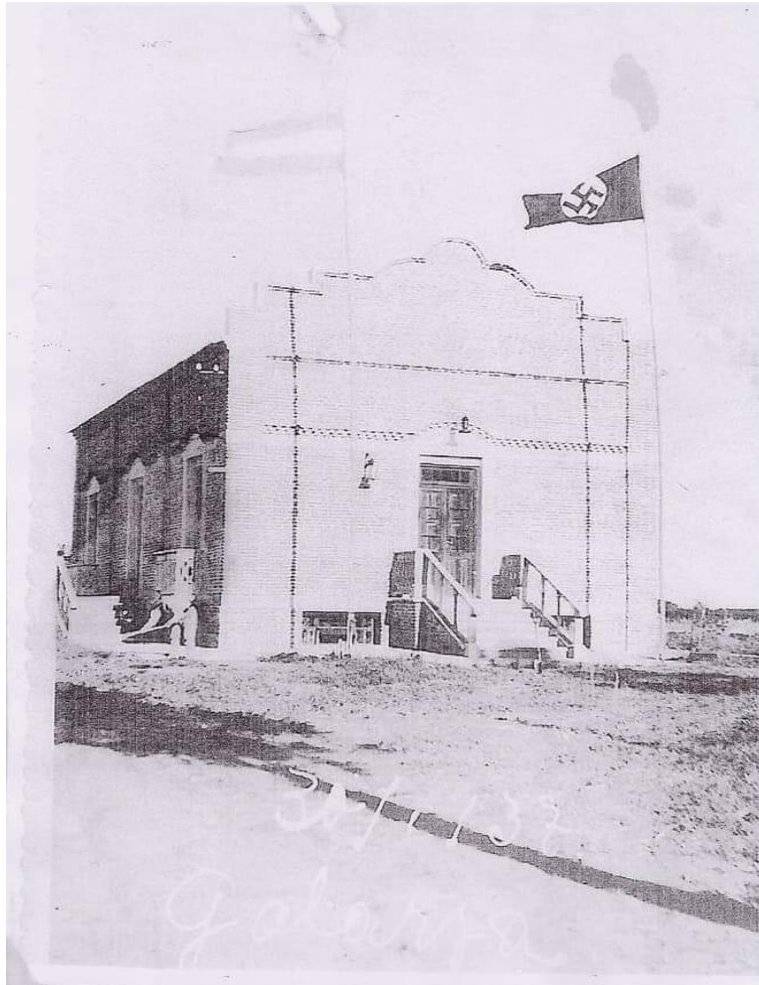
Figura 4. Edificio de la escuela alemana “La Germánica”.
