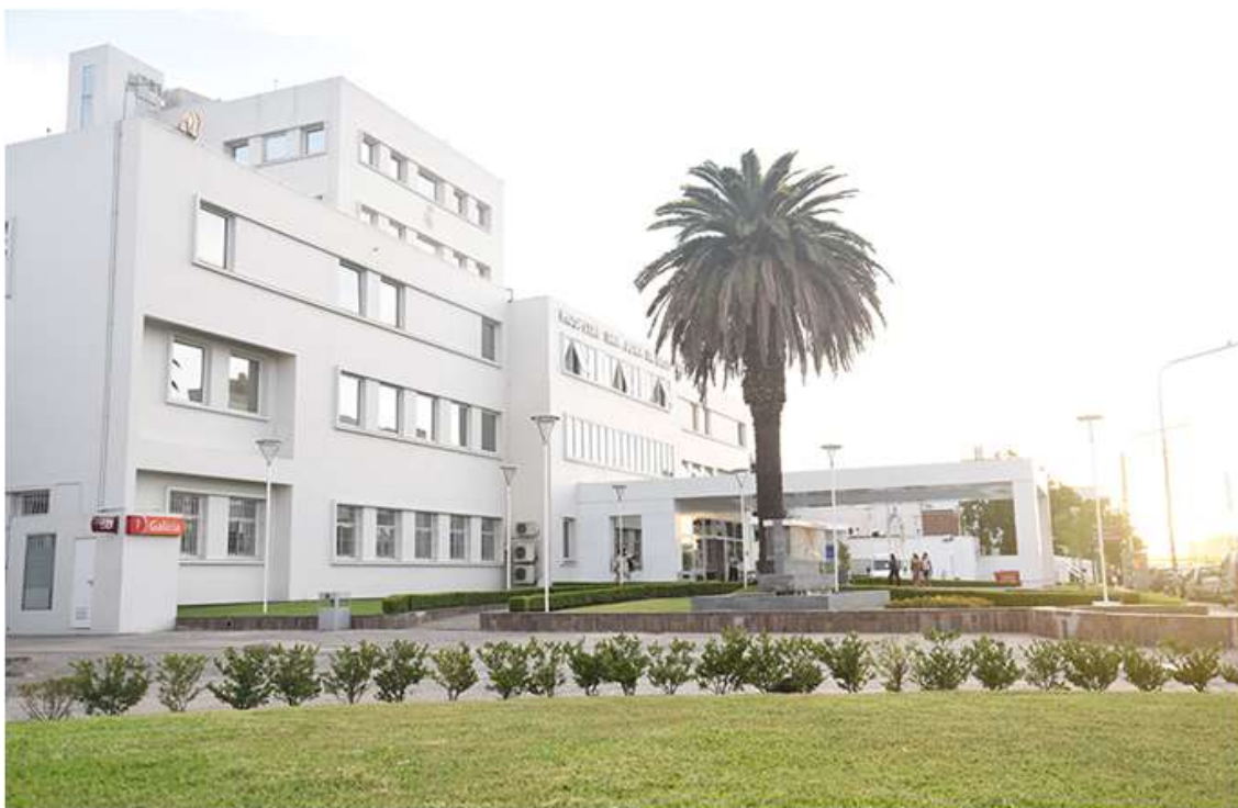
Figura 45. Fachada actual de la Casa Hospital San Juan de Dios (Bortz, J.E. y col., 2017)
